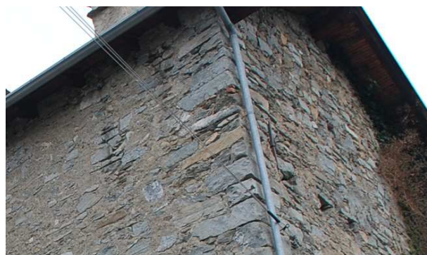
Dettaglio struttura muraria
