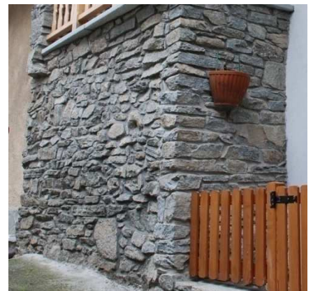
Avancorpo murario rivestito con pietra locale, spessore probabile 20 cm circa, di buona fattura
