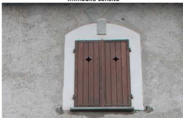
Dettaglio: cornice alla finestra
