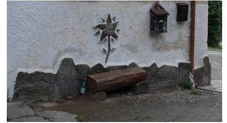
Basamento in pietra locale; losa dal taglio e dimensioni irregolari posata a elementi singoli.
