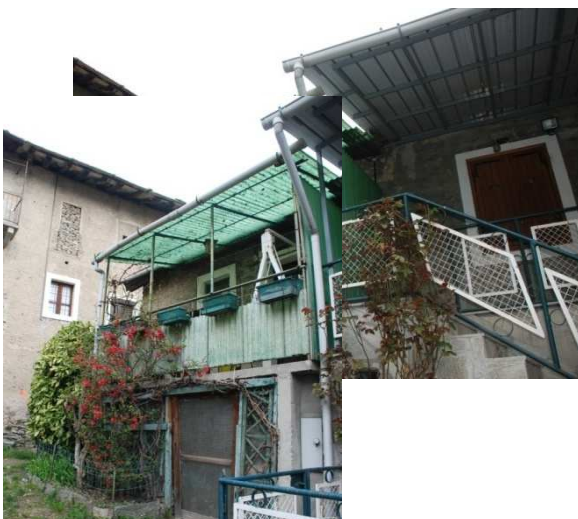
Esempi di terrazze piane, coperture leggere e tettoie presenti in borgata.
