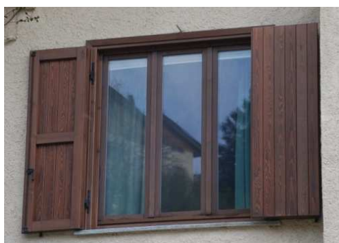
Esempi di serramenti con partitura non appropriata.
