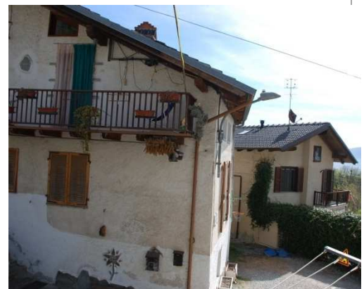
Dettaglio facciata ovest
