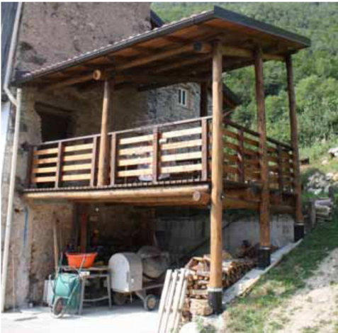
Due validi esempi di mitigazione per terrazze piane e tettoie di servizio, non facenti parte della borgata.
