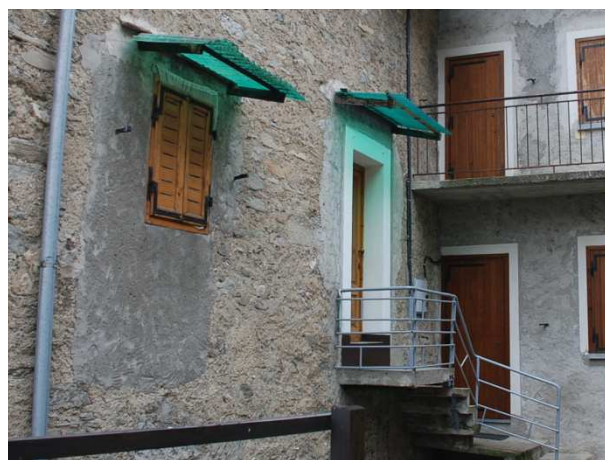
Dettaglio: pensiline facciata laterale
