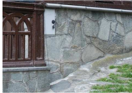
Rivestimento di facciata e muretto di recinzione realizzati a opus incertum con pietra di luserna a spacco. Schema di posa non appropriato
