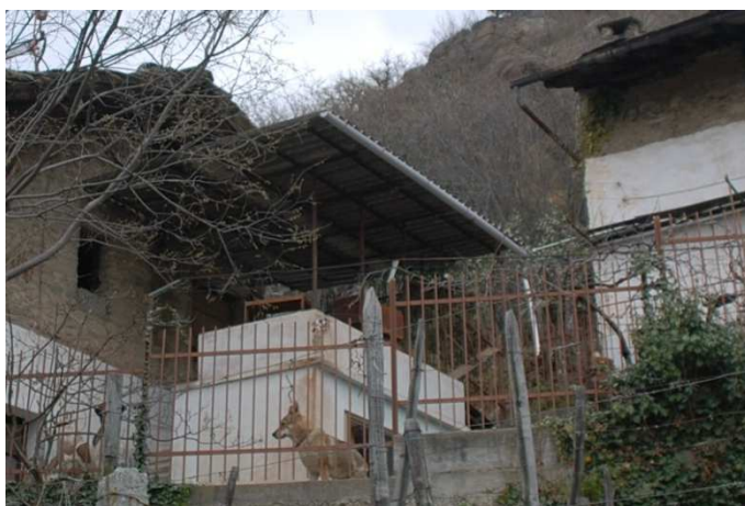
Dettaglio: tettoia posta sul lato est
