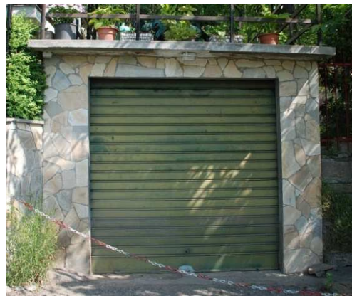
Rivestimento murario decorativo realizzato a mosaico con probabile quarzite di barge. Tipo di pietra e schema di posa non appropriati
