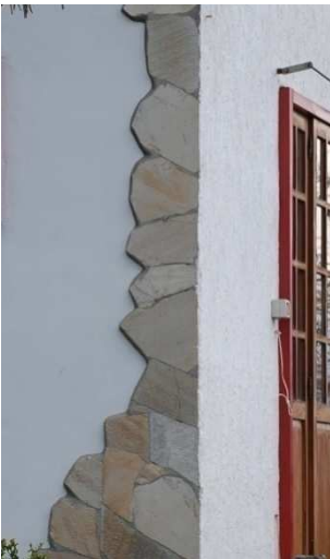
Rivestimento murario decorativo realizzato a mosaico con probabile quarzite di barge. Tipo di pietra e schema di posa non appropriati
