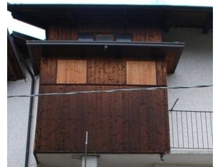
Rivestimenti murari in perline di legno a posa orizzontale e verticale. La non completezza e lo spessore esiguo della perlina accentuano la sensazione di posticcio.
