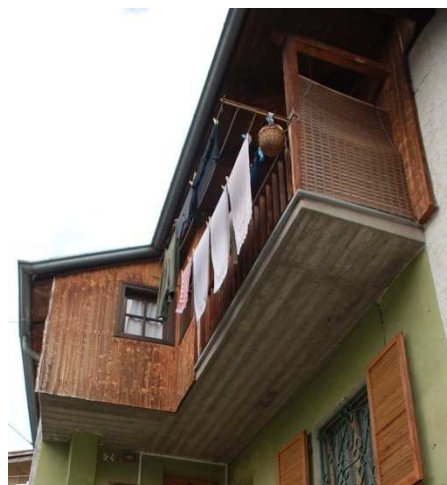
Rivestimenti murari in perline di legno a posa orizzontale e verticale. La non completezza e lo spessore esiguo della perlina accentuano la sensazione di posticcio.
