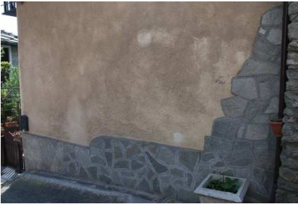
Rivestimento di facciata e muretto di recinzione realizzati a opus incertum con pietra di luserna a spacco. Schema di posa non appropriato
